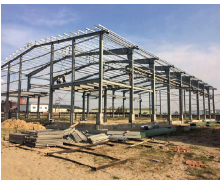
10 THI CÔNG KẾT CẤU THÉP
