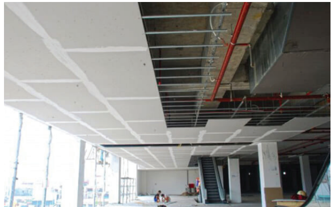
04 Dự án thi công trần thạch cao nội thất nhà ở – Quận 12 - HCM
