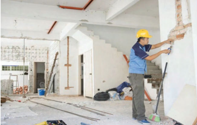
07 Dự án cải tạo sửa chữa nhà dân dụng khu dân cư HCM
