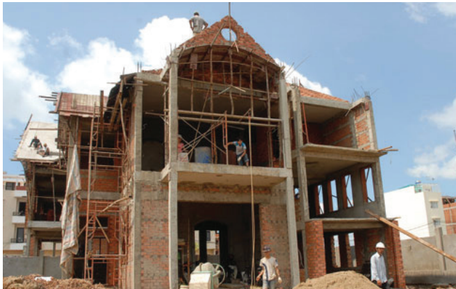
01 Dự án xây dựng hoàn thiện nhà ở trọn gói – TP. Hồ Chí Minh
