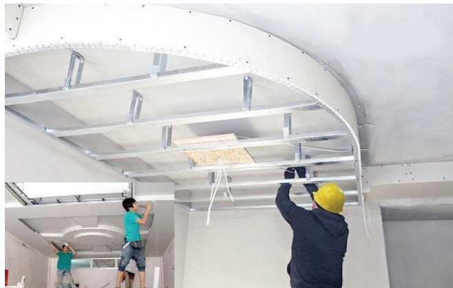
18 Dự án thi công trần – vách thạch cao – Anh Hiếu Chung Cư Masteri Thảo Điền - HCM
