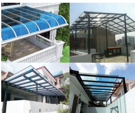
08 THI CÔNG TÔN LẤY SÁNG
