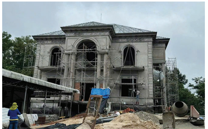
06 Dự án xây dựng và hoàn thiện nhà ở trọn gói – Quận Tân Bình, HCM
