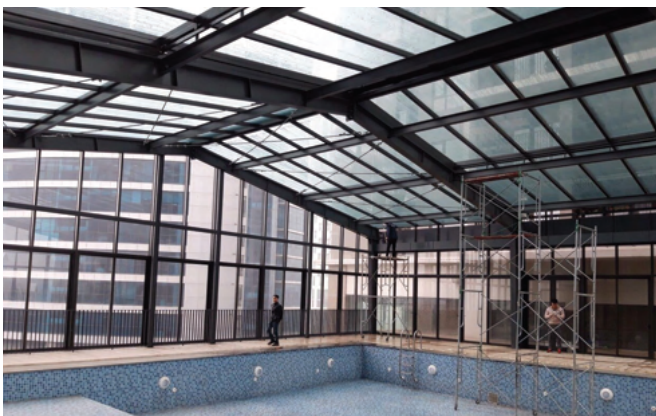
03 Dự án thi công tôn lấy sáng Poly nhà xưởng – Bình Dương
