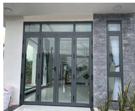
09 THI CÔNG NHÔM KÍNH
