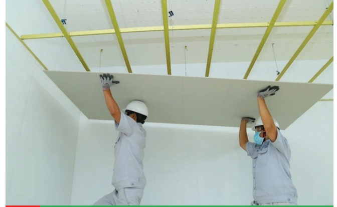
08 Dự án thi công trần – vách thạch cao nhà ở Anh Sáu - Quận 5, TP. HCM
