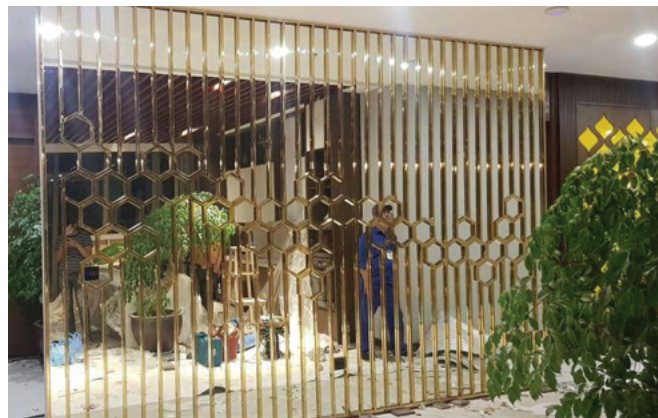
16 Dự án thi công vách ngăn trang trí CNC – Tại Long An
