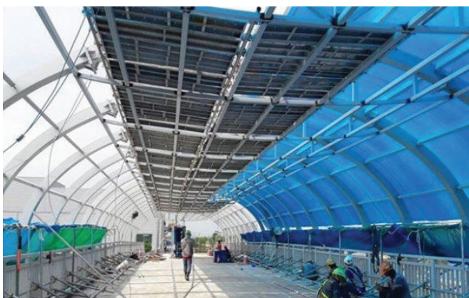
15 Dự án thi công tôn lấy sáng Poly – Công ty Phát Đạt - Bình Dương
