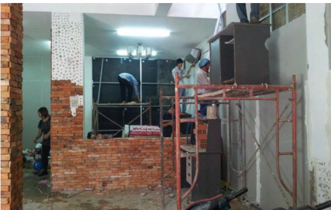
09 Dự án cải tạo sửa chữa nhà dân dụng – TP. Hồ Chí Minh
