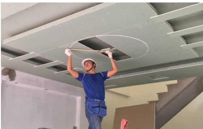
17 Dự án thi công trần thạch cao nhà ở chị Yến – TP. Hồ Chí Minh
