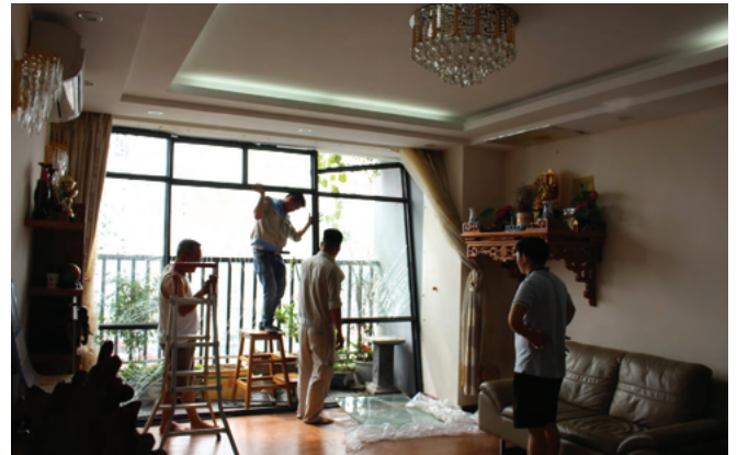
10 Dự án cải tạo sửa chữa nhà phố – Quận 2 Tp. HCM
