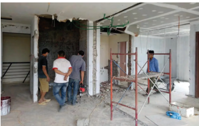
05 Dự án cải tạo sửa chữa nhà dân dụng – Củ Chi - HCM
