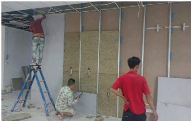
13 Dự án thi công vách thạch cao công trình nhà ở Chị Loan – Q.12, TP. HCM
