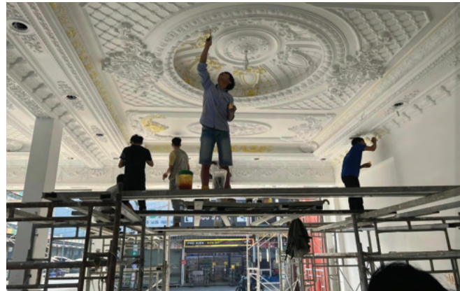
14 Dự án thi công trần thạch cao nhà phố – Anh Cần - Q. 4, TP. HCM
